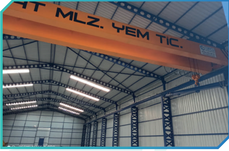
Güleç İnşaat Malz. Mut / 10 Ton
